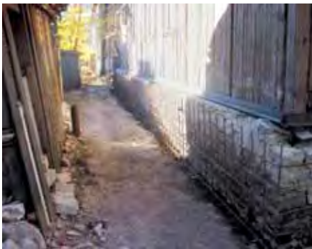
Пример реконструкции и усиления фундамента с использованием акриловой композиции (установка арматурных стержней в пробуренные шпурсы)
