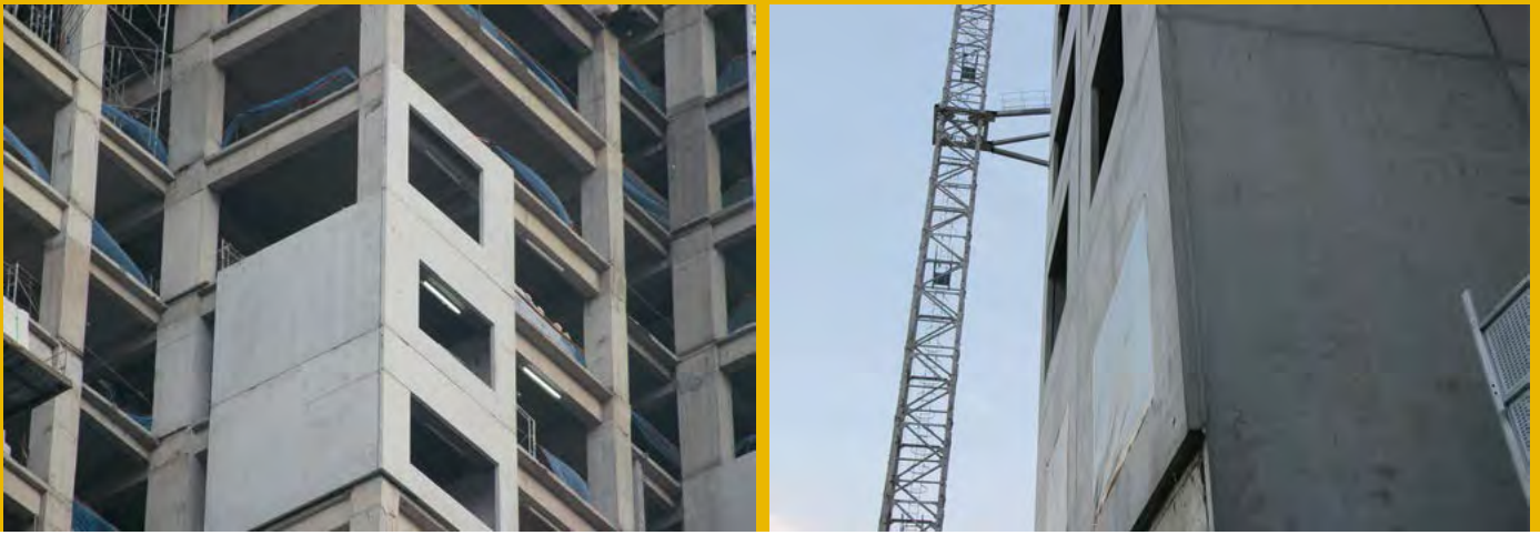
Рис. 2 и 3. Сплошные элементы, изготовленные с применением технологии upcrete будут использоваться в качестве несущих стен для здания с кар-касной конструкцией
