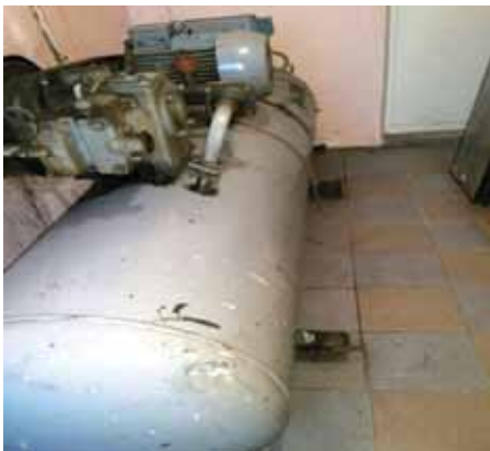
Общий вид конструкции компрессора, закрепленной анкерными болтами на акриловой композиции
