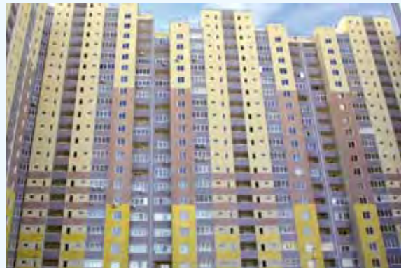
Фото 1. Дом с тепловентилируемым фасадом построен и введен в эксплуатацию компанией «ДСК-4» в 2010 году в Киеве по ул. Закревского, 97. Съемка тепловизором свидетельствует о незначительных потерях тепла
