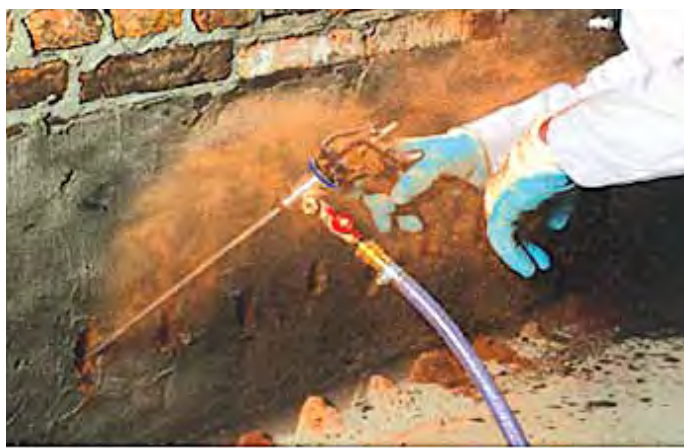
Заполнение шпуров гидроизоляционным составом без давления
