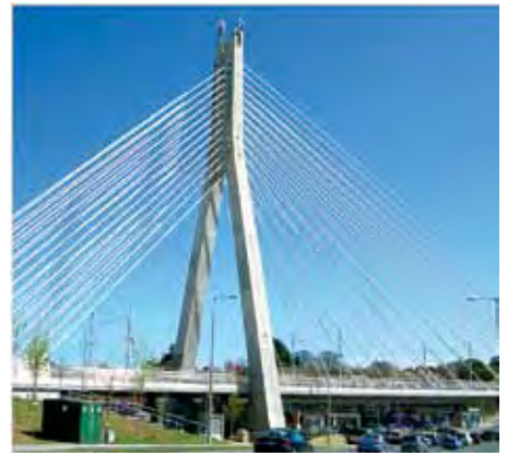
Мост Luas из шлакощелочного бетона в городе Дандрум (Ирландия)
