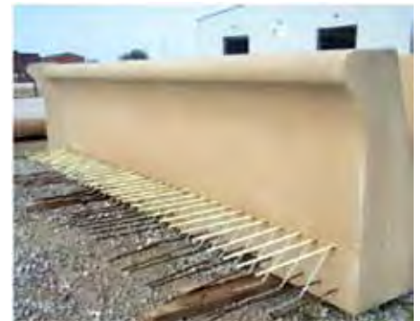
Сборные железобетонные конструкции для укрепления набережной в Блэкпуле (Англия)
