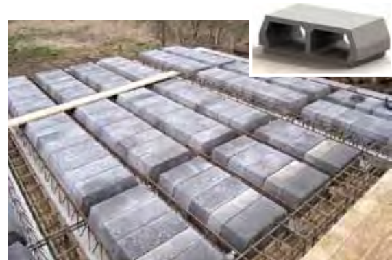
Процесс монтирования сборно-монолитного перекрытия
