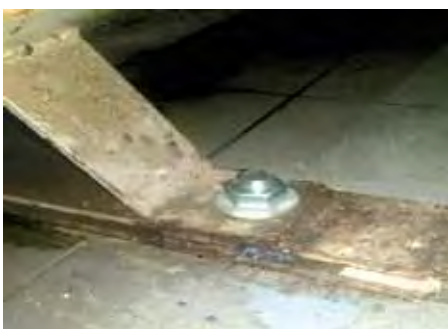
Установка анкерного болта в скважину, заполненную акриловой композицией
