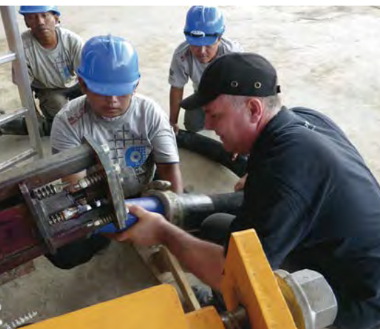
Рис. 10. Монтаж, ввод в эксплуатацию и подробный инструктаж персонала на стройплощадке силами команды Ratec
