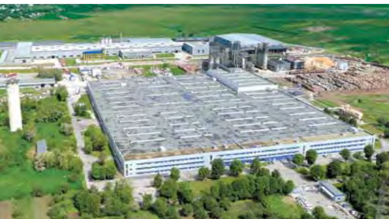
Строительство цеха деревообрабатывающего комбината KRONOSPAN в г. Нововолыньск
